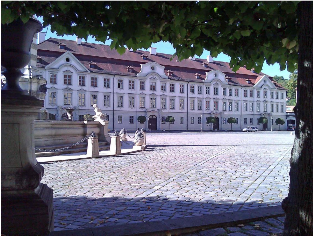
Blick auf die ehemaligen Kavaliershöfe (Abb. 1):
